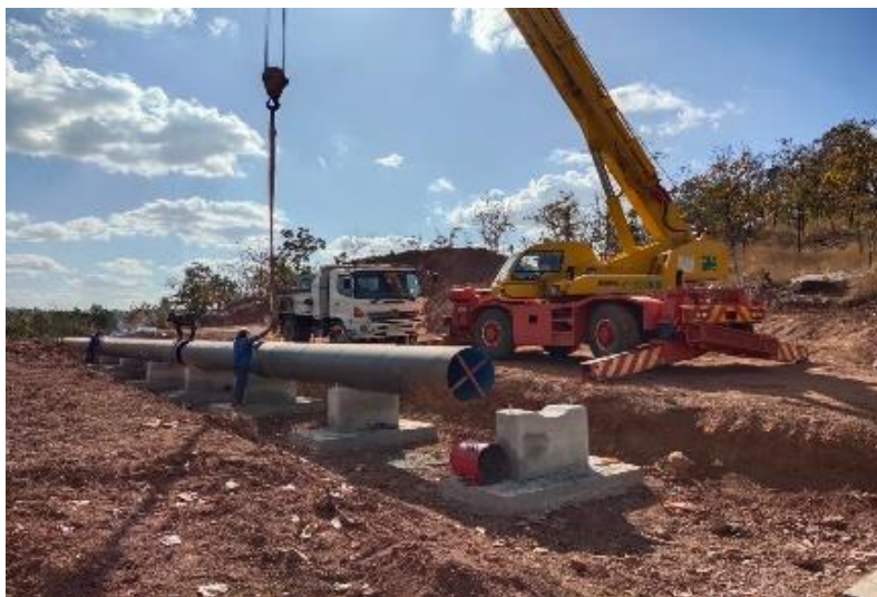
รูปที่ 1.7-5 งานเชื่อมประกอบติดตั้งท่อเหล็กกล้าเชื่อมด้วยไฟฟ้าชนิดบนดิน เส้นผ่านศูนย์กลาง 800 มิลลิเมตร
