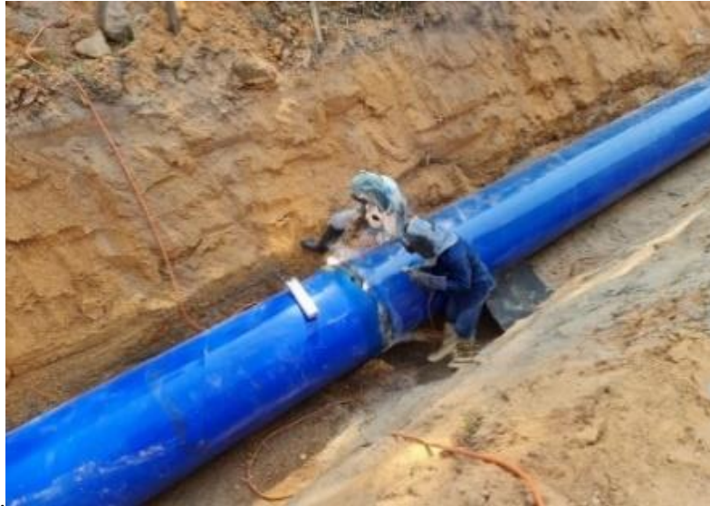
รูปที่ 1.7-6 งานเชื่อมประกอบติดตั้งท่อใต้ดิน
